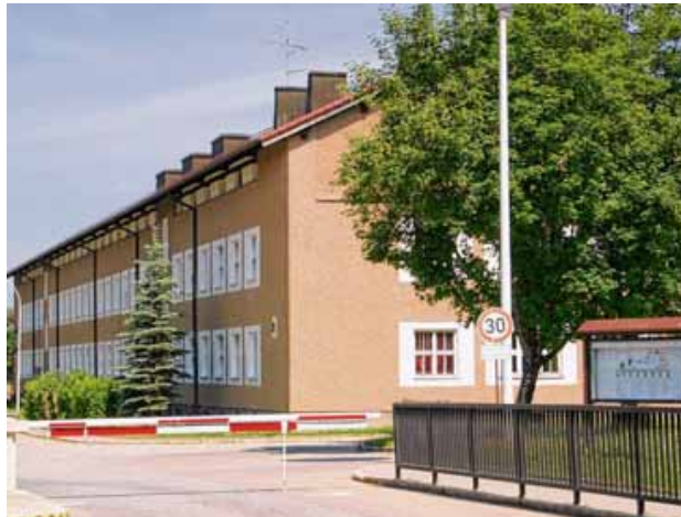
Altes erhalten: Die Grüntenkaserne abreißen? Nicht zwingend nötig für gelungene Baukultur, sagt der Kemptener Stadtheimatpfleger Tilman Ritter. Auch im Altbestand könnten neue Wohnungen entstehen.
